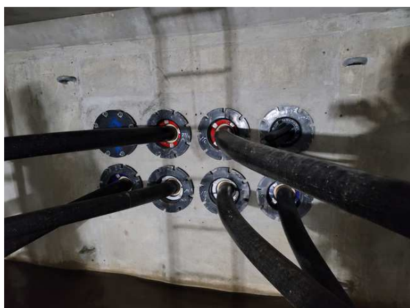
내용 관로구 접속부 상태양호
